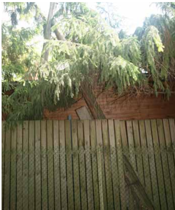
В 4-м переулке столб электропроводки оказался в пределах участка
